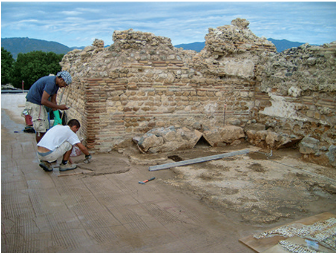
Figura 6 Piccole Terme: Nuova soletta di malta in calce idraulica e frammento di mosaico originario (testimone Pesci) dell' apodyterium . Foto: E. Romoli
