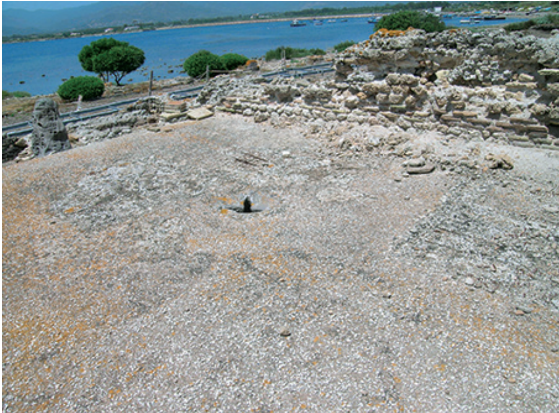
Figura 5 Piccole Terme: Stato di degrado del mosaico del frigidarium ante restauro 2011. Foto: E. Romoli
