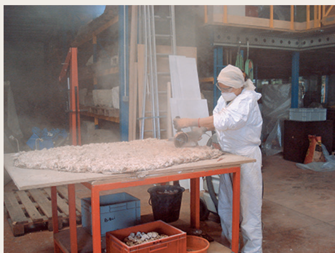
Figure 2 Allégement du mortier au revers, avant restauration. © Inrap. F. Veysière
