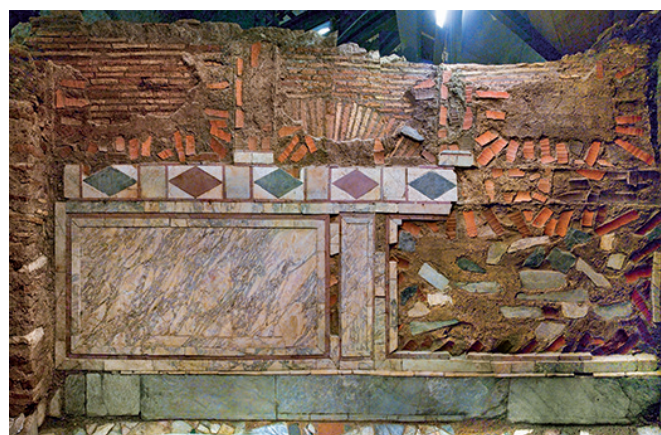
Figura 5 Palazzo Valentini, domus B: Parete est dell'aula absidata con decorazione a opus sectile . Foto: ACC Photo Autuori Carletti Callipari
