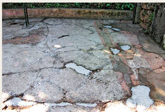
Figure 4 Le tapis de mosaïque après l'intervention de dérestauration et de restauration. Photo: M. C. Hamza
