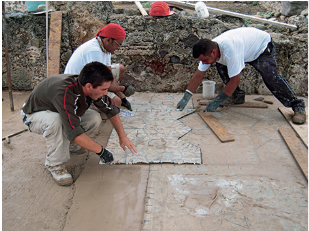
Figura 6 Casa dell'Atrio Tetrastilo, vano D: fase di rimontaggio del mosaico (il copyright è detenuto dagli autori e le immagini sono degli autori)
