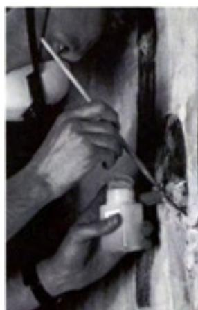
FIGURE 13. REMOVAL OF OLD GAUZE FACINGS.
