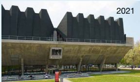
het huidige bitumineuze dakmateriaal is te donker van kleur, zodat door minder schaduwwerking de 'vouwen' niet goed tot hun recht komen
