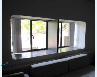
smalle bergruimte afgescheiden; gaten geven toegang tot (installatie-) ruimte tussen aula-bak en tribunes oorspronkelijk: lucht afgezogen onder stoelen; tegenwoordig lucht juist ingeblazen via vloer
