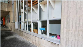
later toegevoegde vergaderruimte verstoort doorzicht vanuit de hal naar buiten en van buiten naar binnen; bovendien zijn suskasten toegevoegd in de gevel (dit ge- veldeel zit verscholen achter de buitentrap)
