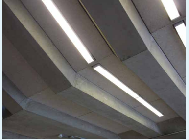
plafond bordes noordzijde
