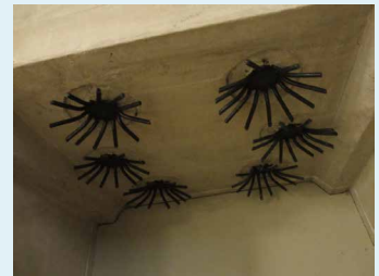
constructedetails vormen educatieve decoratie: boven: einden voorspankabels (hart later dichtgeschilderd) links: opstelruimte Freyssinet voorspan-apparaat
