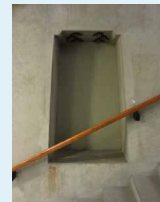
constructedetails vormen educatieve decoratie: boven: einden voorspankabels (hart later dichtgeschilderd) links: opstelruimte Freyssinet voorspan-apparaat
