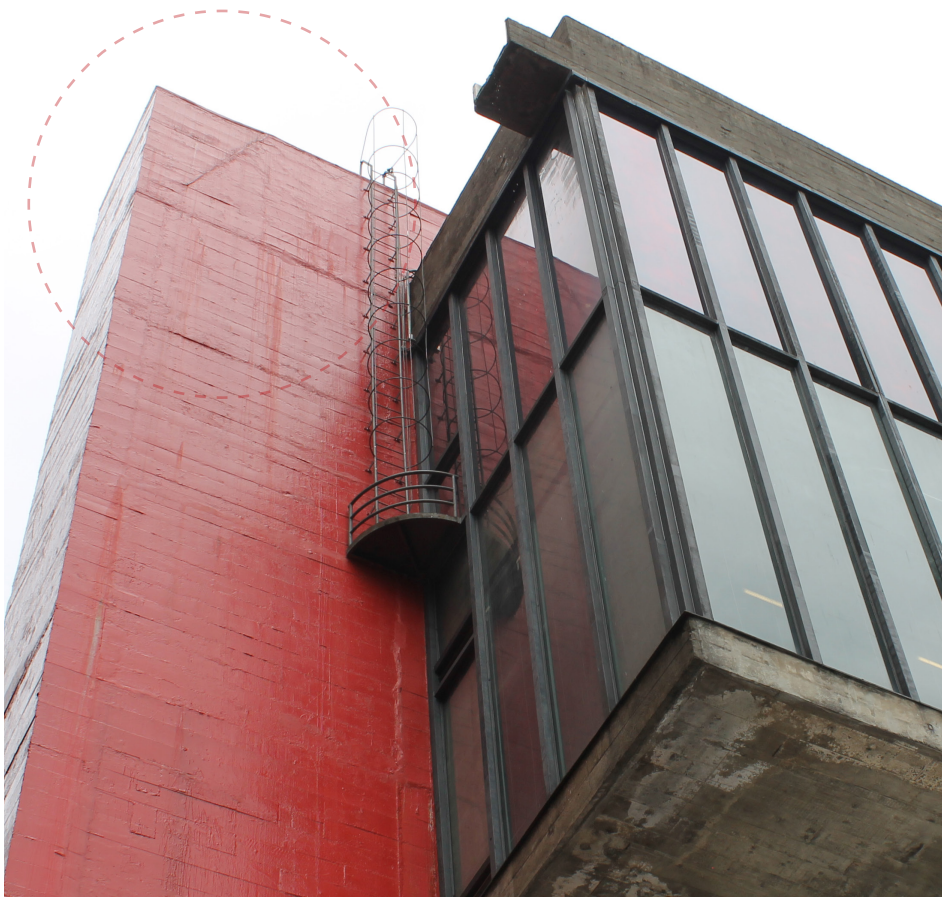
[89] Vista da cunha na viga V2 e da junta de dilatação no encontro da viga com o pilar P2
