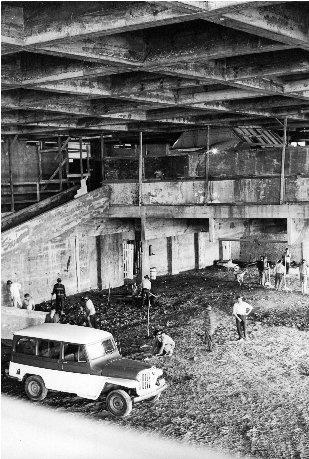
[106] Construção do MASP, 1957-1968
