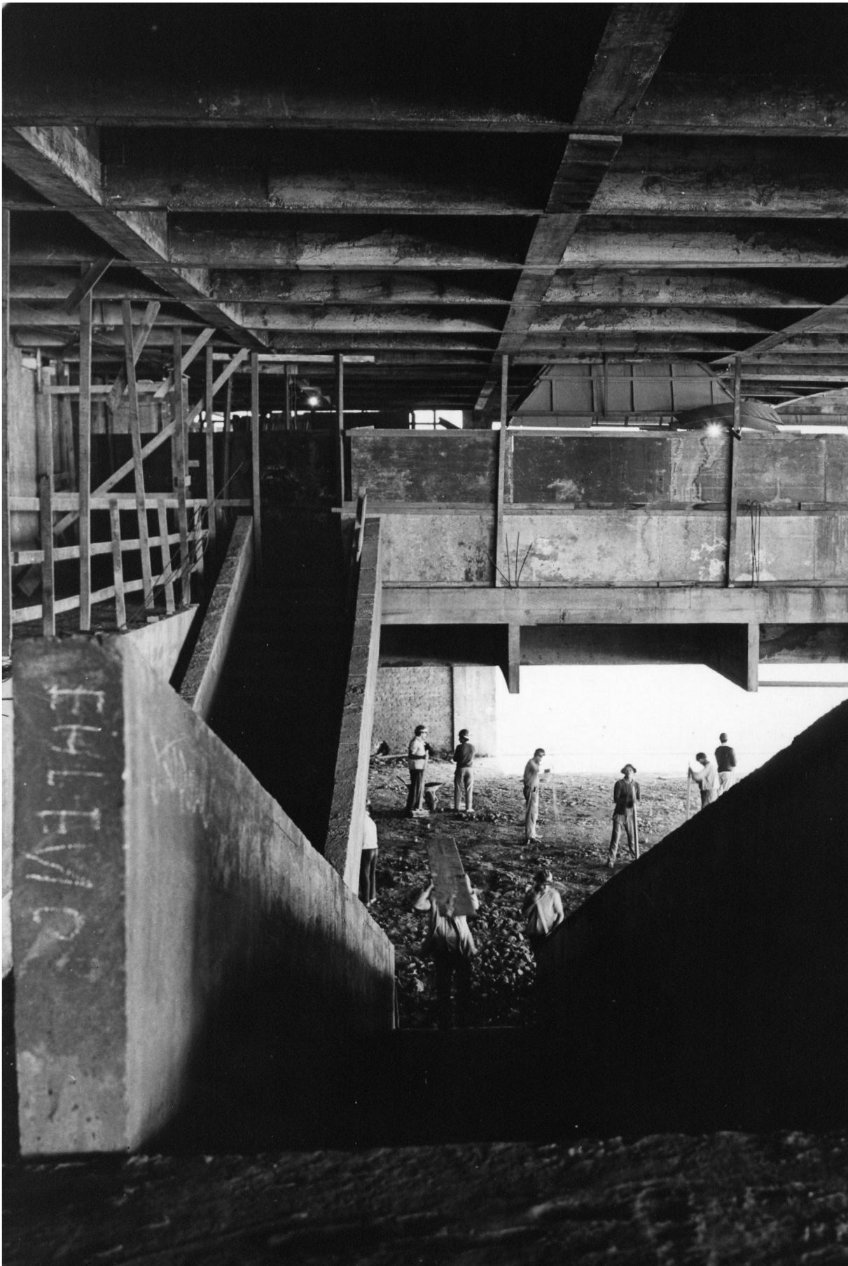
[73] Construção do MASP, 1957-1968
