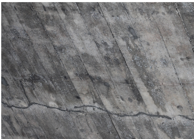
[83] [84] [85] Patologias na laje do primeiro pavimento (teto do Vão-Livre)
