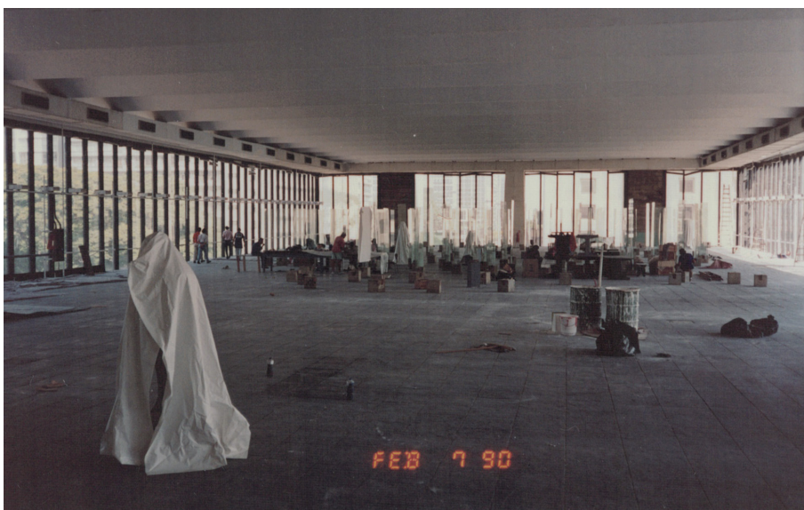
[58] Interdição da Pinacoteca para obras na cobertura, 1989-1990
