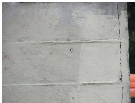
[93] [94] Ponto de referência (pino metálico) no muro, lado R. Otávio Mendes
