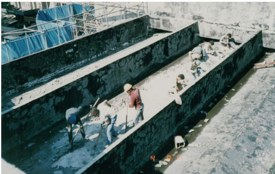
[57] Impermeabilização da cobertura, 1989-1990
