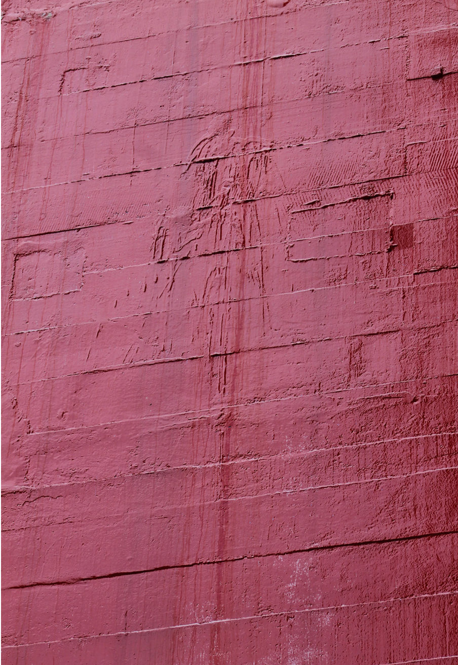
[88] Patologia decorrente da especificação da tinta
