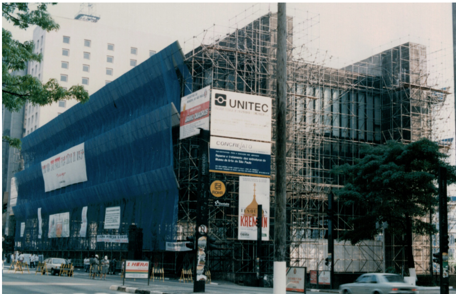
[56] Intervenções no edifício, 1987
