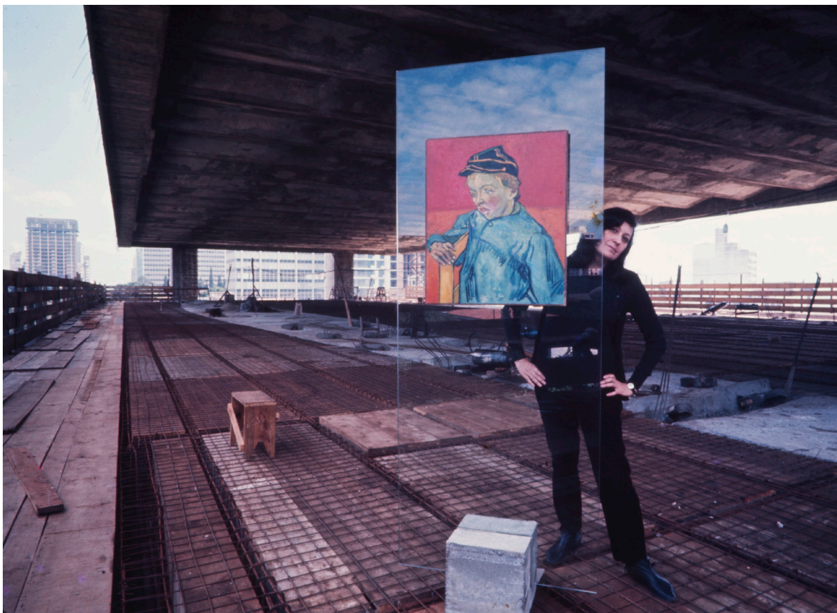
[10] Lina e o Cavalete de Cristal no MASP em construção
