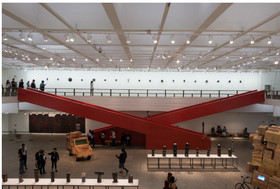
[105] Grelha estrutural da laje do térreo vista do subsolo (teto)
