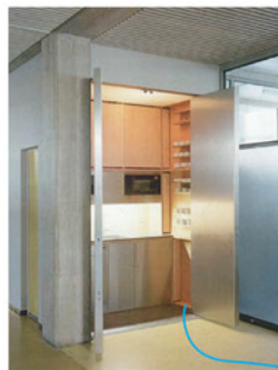
in 2008 toilet verbouwd tot 'verstoppe' pantry (foto Kim Zwarts)
