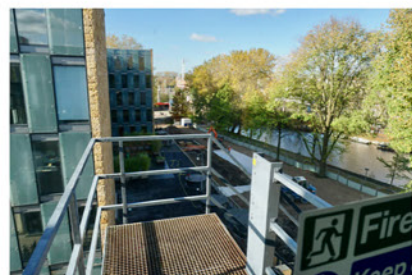
bovenste platform van de stalen buitentrap
