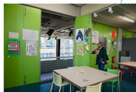
wandpanelen met bovenlichten vervangen door opendraaiende deuren
