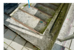
trap met stalen trapneuzen
