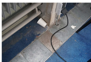
zeer zichtbare kabelgoot
