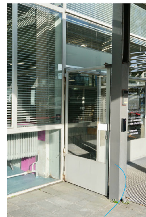
er zijn diverse zaken bevestigd aan de kolommen bij de entree; hier is zelfs het H-profiel opgevuld
