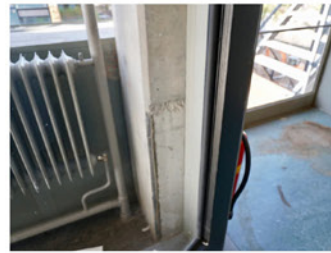
spoor van verwijderd aanrecht
