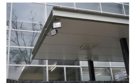
originele entreeluifel; ook plafond en lichtarmaturen origineel (luifel van buitenwerkplaats heeft hetzelfde randdetail)
