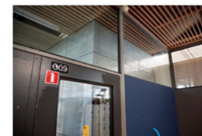
trappenhuis oorspr. in open verbinding met gevel
