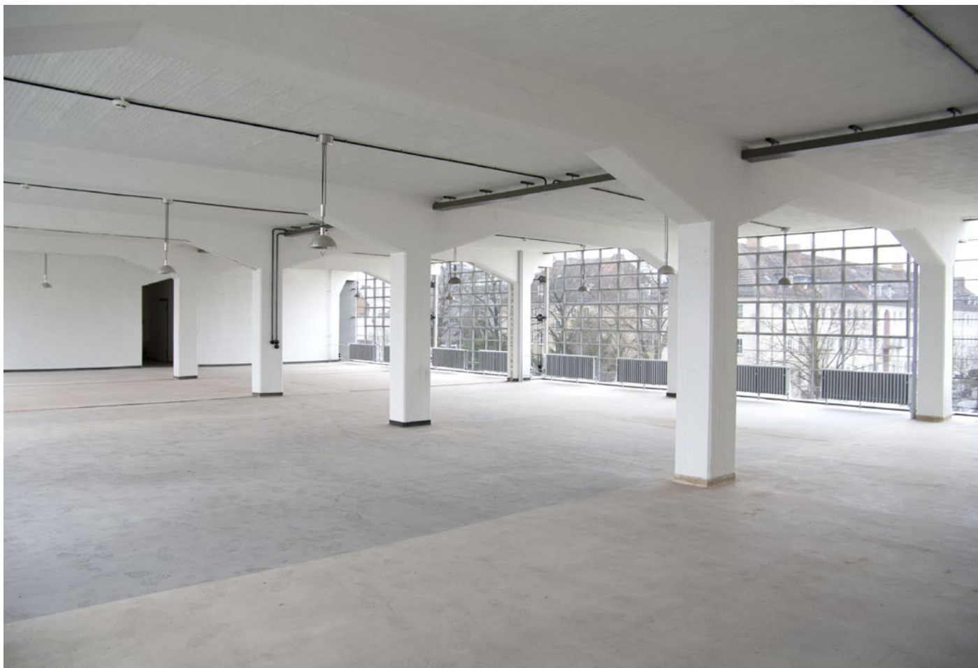
Sichtbare Konstruktion im Werkstattflügel, 2012 / Stiftung Bauhaus Dessau / Foto: Yvonne Tenschert
