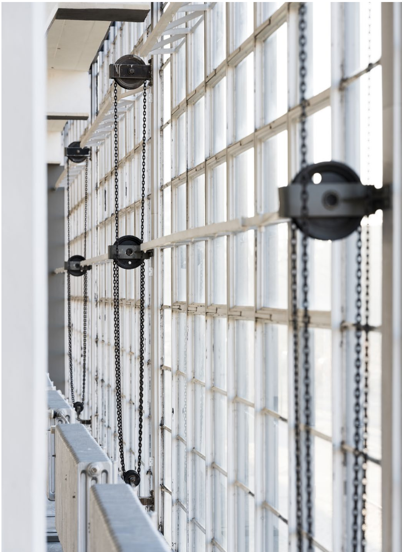
Vorhangfassade am Bauhaus, 2021 / Stiftung Bauhaus Dessau / Foto: Thomas Meyer / OSTKREUZ
