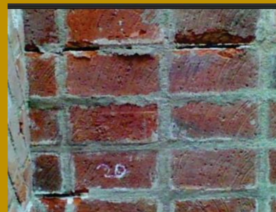
Apreciación a simple vista de las armaduras de refuerzo debido a la oxidación del metal dentro del mortero de las juntas debido a la filtración de agua, apreciable en la diferencia de temperatura que manifiesta el cambio de color. Fotos IET-FIng
