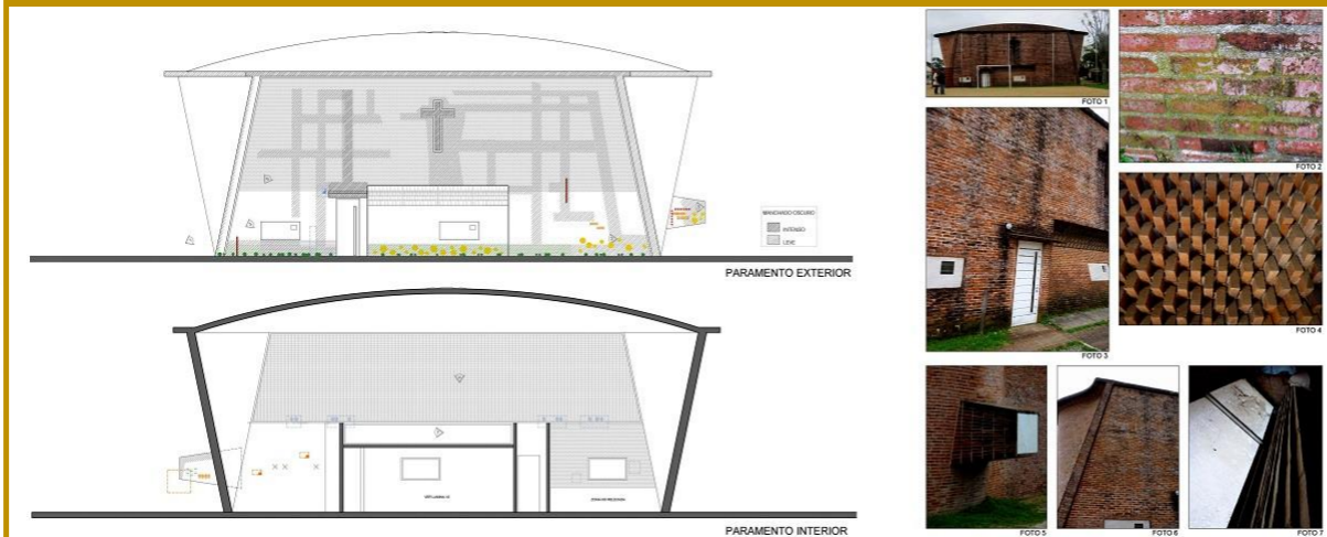
Deterioros y patologías en las fachadas norte v sur, interior v exterior. FADU-IC
