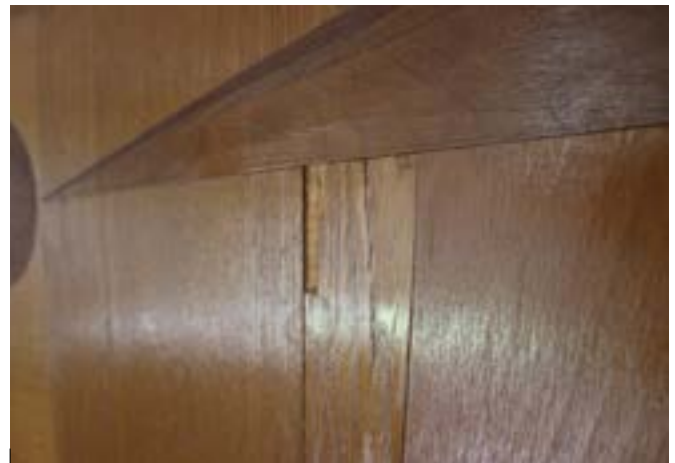
ვერტიკალურად მოძრავი მარკეტრის პანელების ზედაპირული დაზიანება
