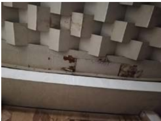
ფოტო 21. მაყურებელთა დარბაზში სახურავიდან წყლის ჩამოსვლის შედეგად დაზიანებული შეკიდული ტერი
