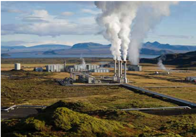
Figura 2.4. Central eléctrica geotérmica Nesjavellir, 1990, Thingvellir, Islandia. Esta instalación, la segunda central hidroeléctrica geotérmica más grande en Islandia, cubre los requisitos de calefacción y agua caliente de Reikiavik mediante el aprovechamiento del calor terrestre y el uso de agua subterránea con el fin de operar una turbina que genera electricidad. A principios de siglo XX, la creciente demanda de electricidad provocó la búsqueda de nuevas fuentes de energía eléctrica. La electricidad geotérmica se produjo comercialmente por primera vez en Italia en 1913. Mientras en otros países experimentaron con ella, no fue hasta 1958 que la segunda gran planta geotérmica abrió sus puertas en Nueva Zelanda. Siguieron centrales adicionales, continuando con la creciente búsqueda de fuentes de centrales eléctricas.
