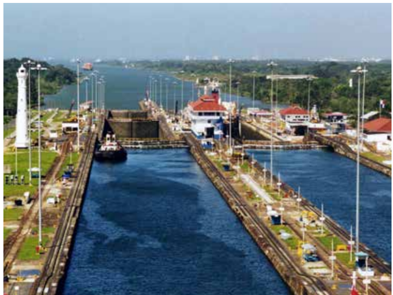
Figura 4.8. Lago Gatún, Canal de Panamá, ca. 1913, Panamá. En 1881, Francia comenzó a construir un canal a través del istmo de Panamá. Estados Unidos tomó el control en 1904 y se construyeron una serie de esclusas a lo largo de una trayectoria de 82 km para crear un vínculo entre los océanos Atlántico y Pacífico. El proyecto también involucró la construcción de varias estructuras auxiliares relacionadas con el mantenimiento del canal. Abierto al tránsito en 1914, el canal de Panamá sirvió como una vía importante de comercio y transporte a nivel internacional durante todo el siglo. En 1999, el control del canal se transfirió de Estados Unidos a Panamá.
