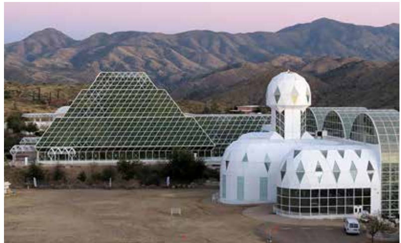
Figura 2.14. Biósfera II, 1987-91, Oracle, Arizona, EE. UU. Esta innovadora instalación de investigación científica se diseñó para emular el medioambiente de la Tierra para evaluar si los seres humanos podían construir colonias autosustentables en el espacio exterior. Esencialmente un terrario gigante, la estructura hermética de acero y vidrio de 1,27 hectáreas contiene 5 biomas, incluyendo viviendas y áreas agrícolas. Es el sistema cerrado más grande jamás construido. En 1991, un equipo conformado por cuatro hombres y cuatro mujeres habitaron herméticamente el lugar durante un periodo de dos años para el estudio de la capacidad de supervivencia, una segunda misión mucha más corta se llevó a cabo en 1994. Lo opera actualmente la Universidad de Arizona.
