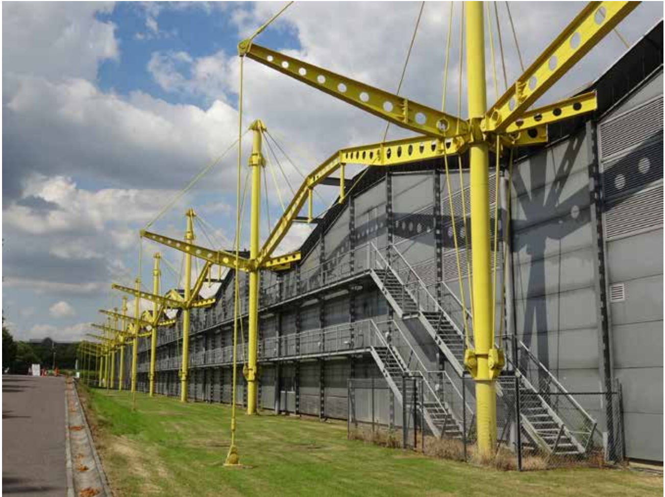
▲ Figura 4.3. Centro de distribución de Renault, 1982, Swindon, Inglaterra. Durante la década de 1970, la compañía automotriz francesa Renault Group comenzó a expandirse globalmente. Diseñada en el estilo High-Tech británico del arquitecto originario de Manchester, Norman Foster, esta instalación industrial altamente innovadora incorporó nuevos materiales, tecnología y soluciones de diseño que le permitieron un interior flexible y expandirse. Renault se mudó en 2001, y ahora la estructura se conoce como el Edificio Spectrum.
