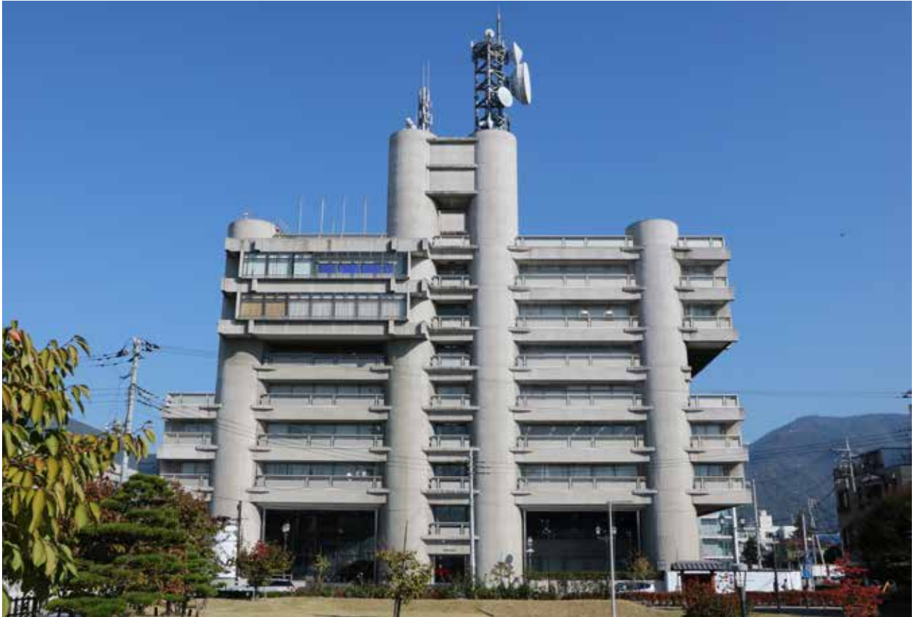
Figura 5.11. Yamanashi Press y centro emisor 1961–66, Kōfu, prefectura de Yamanashi, Japón. Diseñado por el arquitecto metabolista japonés Kenzo Tange, este edificio de hormigón moldeado en su sitio se planeó para albergar tres funciones de comunicación importantes: una planta de impresión de periódicos, una estación de radio y una emisora de televisión. Tales funciones eran visibles en el diseño de la fachada; el equipo de impresión se ubicaba en la planta baja, estudios sellados en los pisos superiores, oficinas de muros de vidrio con balcones, y pozos cilíndricos de servicio para las escaleras, elevadores y HVAC. Además, se incorporaron espacios abiertos de planta libre y fluidas transiciones hacia el espacio urbano del exterior.
