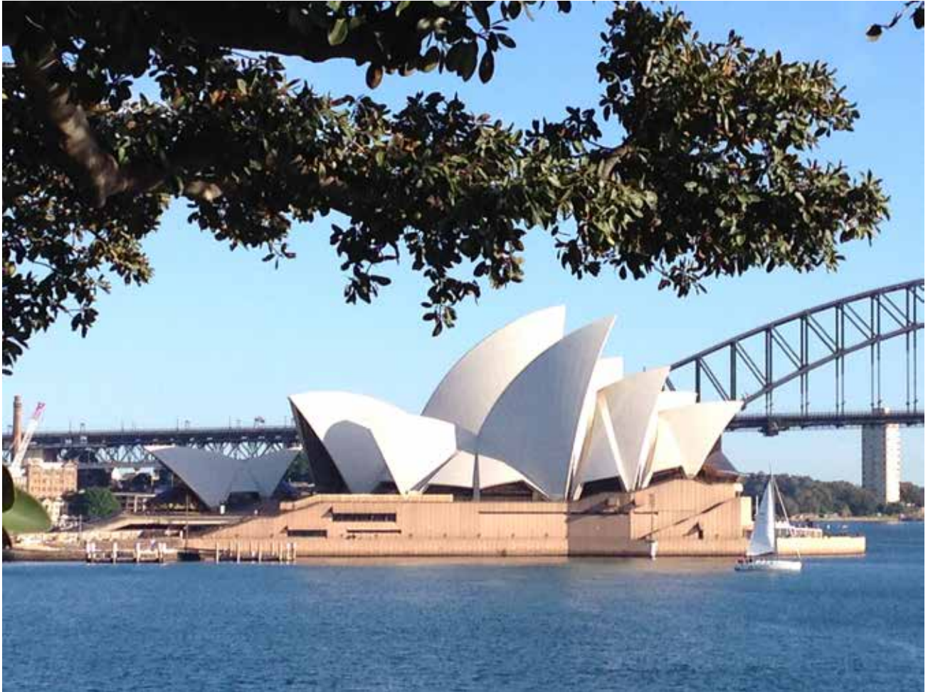
▲ Figura 2.5. Casa de la Ópera, 1958-73, Sidney, Australia. Diseñada por el arquitecto danés Jørn Utzon, quien trabajó con el ingeniero de estructuras de origen británico Ove Arup, la estructura presenta tres grupos interconectados de estructuras laminares de hormigón abovedado, montadas sobre un podio monumental en la península del puerto. Para entender las fuerzas complejas a las cuales están sometidos los paneles curvos y arcos prefabricados, los diseñadores fueron de los primeros en utilizar computadoras en el análisis estructural. El sitio se inscribió en la Lista del Patrimonio Mundial en 2007 como una «obra maestra del genio creativo de la humanidad».
