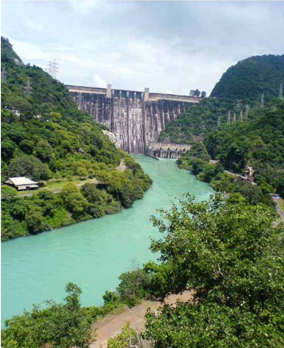
▲ Figura 3.1. Presa Bhakra, 1963, Bilaspur, Himachal Pradesh, India. Con 226 metros de altura, esta presa de gravedad de hormigón es la más alta en India y está entre las más altas del mundo. La presa contiene al río Satluj para crear la reserva más grande de India, reteniendo el exceso de agua durante un monzón y proveyendo la liberación regulada durante el año. La presa suministra el canal Bhakra, que provee irrigación a 4 millones de hectáreas en Punjab, Haryana y Rajasthan. La energía eléctrica producida por los generadores de la presa se distribuye a Himachal Pradesh y a los cinco estados vecinos.
