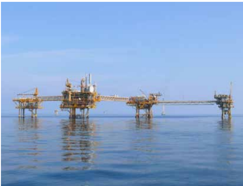
Figura 2.2. Campo petrolero Mubarek, 1974, Sharjah (ultramar), Emiratos Árabes Unidos. Tales plataformas de perforación petrolera en ultramar, las cuales comprenden pozos, una plataforma de procesamiento y estructuras de soporte, fueron erigidas por Crescent Petroleum Company a principios de la década de 1970 para facilitar la extracción rápida de más de sesenta mil barriles de petróleo al día. Reflejan la manera en la que ingenieros capacitados habían descubierto y distribuido el petróleo para su exportación y la obtención de ganancias, especialmente, en la región del golfo Pérsico.
