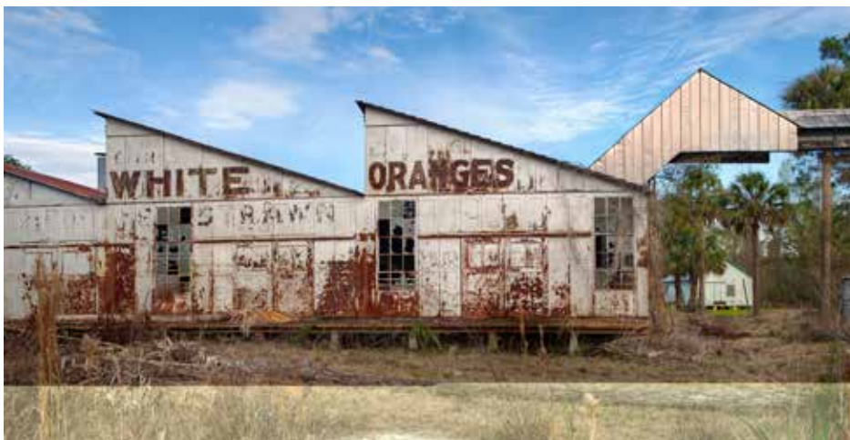
Figura 3.6. Distrito de Strawn Citrus Packing House, 1921, De Leon Springs, Florida, EE. UU. La moderna planta empacadora de fruta, con su sistema automatizado de correas transportadoras y poleas, permitió el movimiento de grandes volúmenes de productos. La proximidad a las líneas ferroviarias y, posteriormente, a las carreteras significó que los productos se podían enviar a grandes distancias. Sin embargo, la dependencia en las altas producciones de cultivos únicos dejó a los productores de naranjas, al igual que a otros agricultores, vulnerables a una serie de condiciones. En 1983, la compañía Theodore Strawn (también conocida como la empacadora Bob White) colapsó después de que una helada inesperada diezmará sus campos de naranjas.
