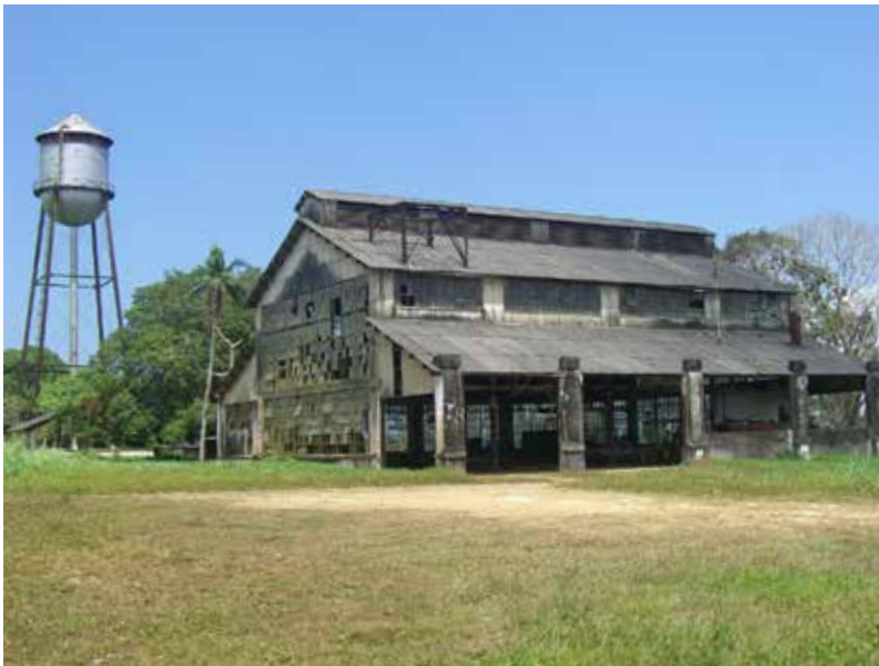
Figura 4.2. Central eléctrica de la Ford Motor Company (abandonada), ca. 1929, Fordlandia, Brasil. En búsqueda de una fuente de caucho para su uso en la fabricación automotriz, el industrial estadounidense Henry Ford fundó Fordlandia en la selva tropical del Amazonas en 1928. Concebida como una idílica ciudad empresarial para los brasileños empleados por Ford, tuvo la intención de ser un experimento social e industrial. Malas decisiones empresariales, incluyendo la falta de experiencia en el cultivo de caucho, en combinación con intentos no deseados de imponer las normas culturales y la cultura corporativa estadounidenses en los trabajadores locales, condenaron el proyecto al fracaso. Hacia finales de la década de 1930, Ford había abandonado en gran medida la ciudad, se retiró por completo en 1945 y vendió de vuelta las tierras al Gobierno brasileño como una gran pérdida.
