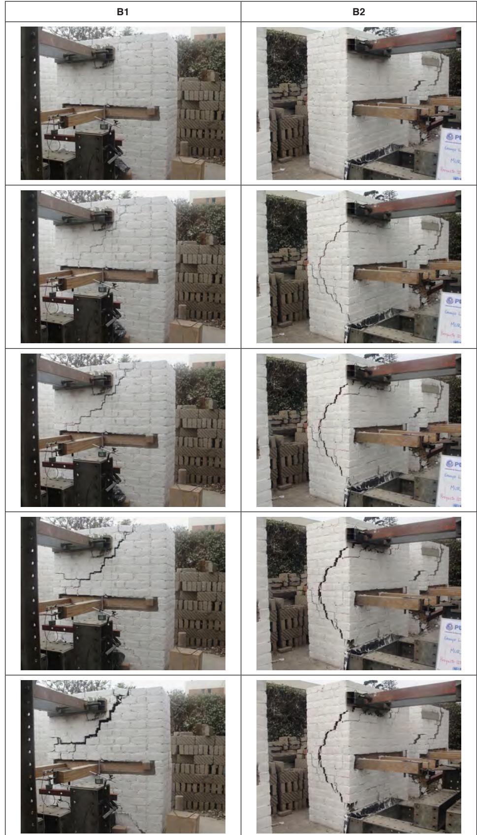
FIGURA 6.19. Propagación de grietas durante los ensayos de los especímenes tipo B.
