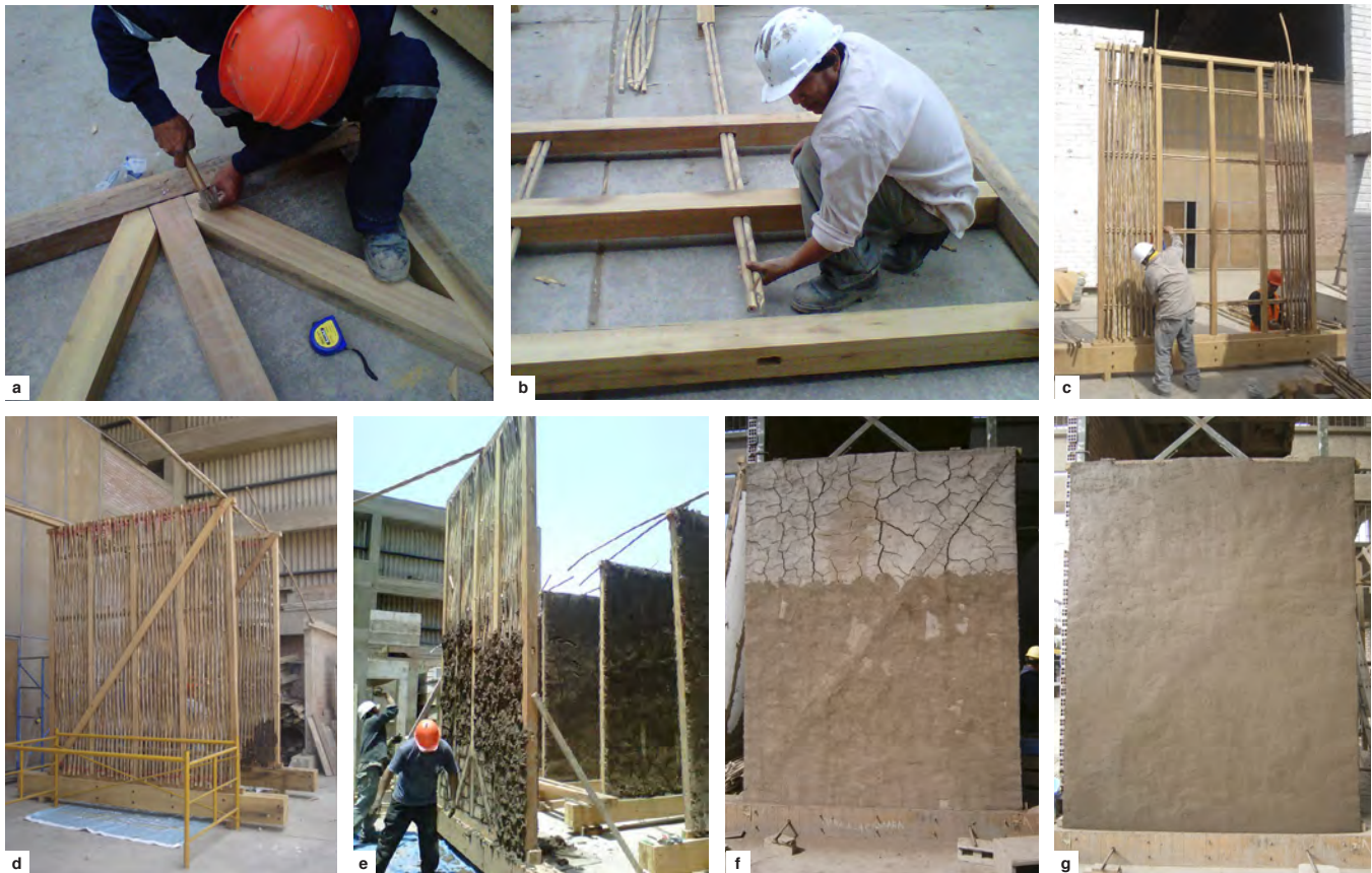
FIGURA 4.7. Construcción de un panel nuevo de quincha para ensayo: (a) sujeción de la citara (elemento diagonal en el zócalo), representativa de la estructura del segundo piso (MA); (b) inserción de las cañas transversales en los postes; (c, d) construcción del panel del tercer piso (MB) con elemento de madera diagonal; (e) relleno del panel (MA) con mortero de barro; (f) panel de quincha que muestra el agrietamiento por contracción en la primera capa del revoco de barro; (g) panel de quincha después de la aplicación de una segunda capa de revoco de barro.
