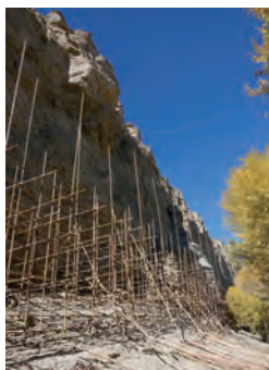
崖体稳定包括岩石加固和锚杆（索）加固。（莫高窟）
