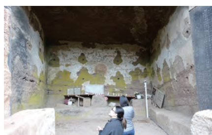
潮湿导致洞窟壁上微生物生长 (云崖寺石窟)
