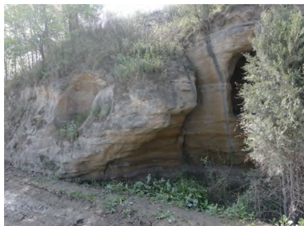
处于潮湿地区的石窟寺，更应该加强日常维护，防止因土壤积水、植被生长而加剧石窟劣化。
