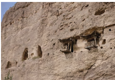
自然侵蚀、废弃造成的石窟劣化与崖体剥落。可溶盐造成壁画劣化(莫高窟，现已修复) (童子寺石窟)
