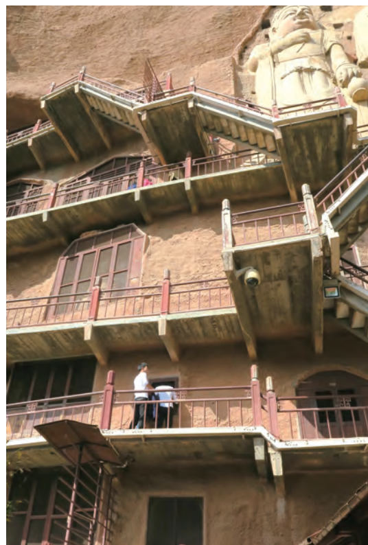
崖体加固、修建栈道和窟门有助于稳定崖面。（榆林窟）
