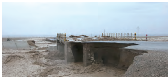
强降雨形成洪水，冲毁通往莫高窟的路面和桥梁。 (莫高窟，2012年6月5日)
