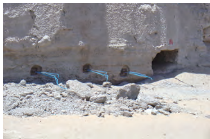
崖体稳定包括岩石加固和锚杆（索）加固。（莫高窟）
