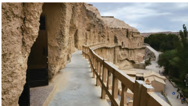
崖体加固、修建栈道和窟门有助于稳定崖面。（榆林窟）
