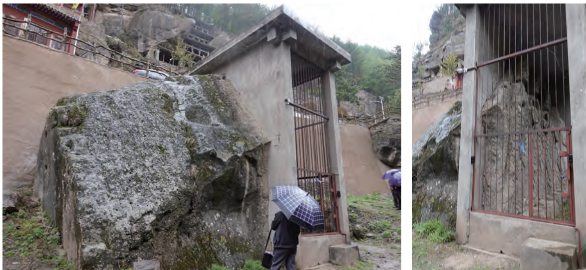
保护性结构是遗产地的一种保护措施。在上图中，该结构的设计和材料对石窟寺及其要保护的雕塑的美学价值产生了负面影响。（陈家洞石窟）
