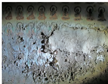
自然侵蚀、废弃造成的石窟劣化与崖体剥落。可溶盐造成壁画劣化(莫高窟，现已修复) (童子寺石窟)
