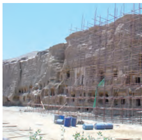
崖体稳定包括岩石加固和锚杆（索）加固。（莫高窟）
