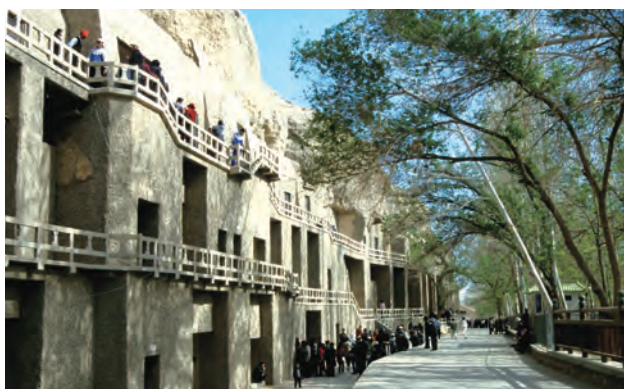
崖体加固、修建栈道和窟门有助于稳定崖面。（榆林窟）
