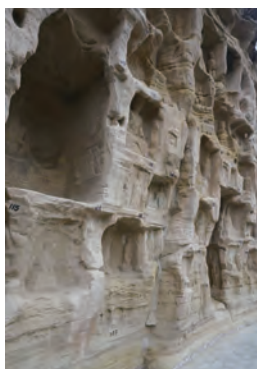
崖面侵蚀与岩体失稳。(北石窟寺与五个庙石窟)
