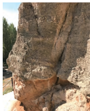
崖面侵蚀与岩体失稳。(北石窟寺与五个庙石窟)
