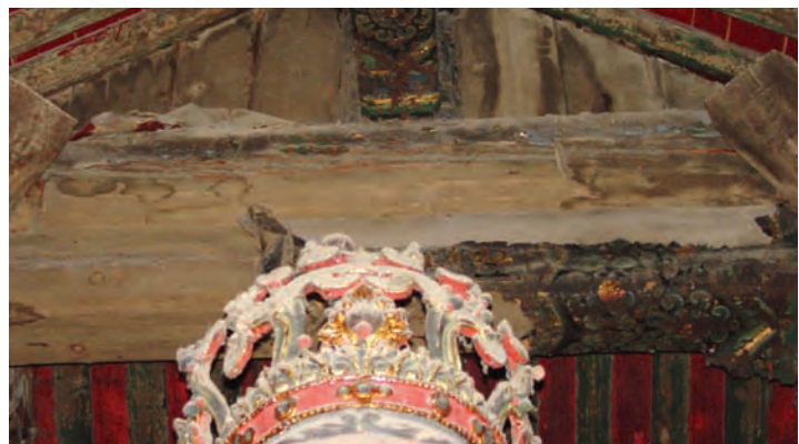
局部照片，可见踩步金上的彩画缺失及暴露木材上的水迹。
