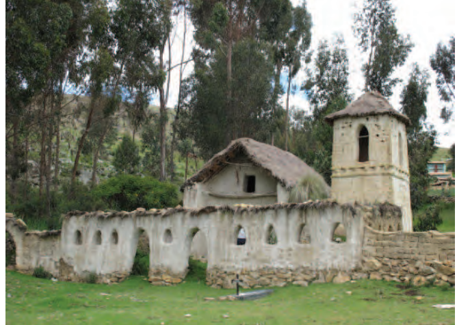
FIGURA 1.4 Capilla de la Virgen Concebida, Kuchuwasi, cerca del Cuzco, Perú. Edificación construida de tierra. Imagen: Claudia Cancino.
