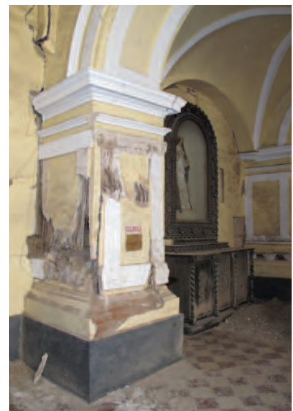
FIGURA 4.24 Vista de una pilastra de quincha del muro lateral. Imagen: Sara Lardinois.
