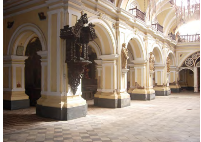
FIGURA 4.11 Vista de los pilares entre la nave principal y las naves laterales, 2007. Imagen: Philippe Garnier.
