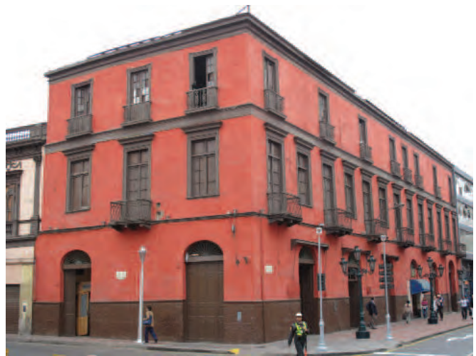
FIGURA 3.2 Vista de la esquina del Hotel Comercio. Imagen: Amila Ferron.
