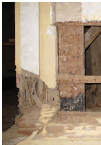
FIGURA 4.23 Vista de la base de ladrillo de un pilar. Imagen: Sara Lardinois.
