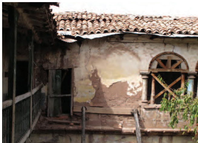
FIGURA 6.47 Vista de arco tapiado en el lado sur del patio. Imagen: Sara Lardinois.
