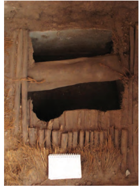
FIGURA 6.30 Vista fotográfica de la cala IIW-1 que muestra la configuración del entrapiso en la esquina noreste de la habitación A-203. Imagen: Claudia Cancino.
