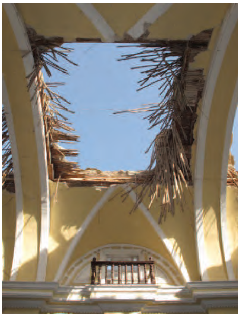
FIGURA 4.50 Sector C: Vista de la bóveda de cañón colapsada en una crujía de la nave principal. Imagen: Sara Lardinois.
