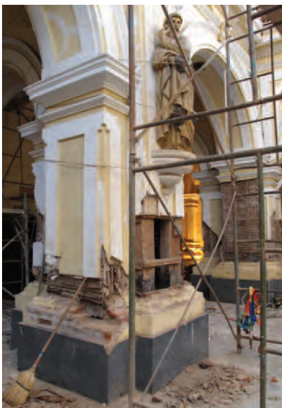
FIGURA 4.22 Vista de un pilar de quincha. Imagen: Sara Lardinois.
