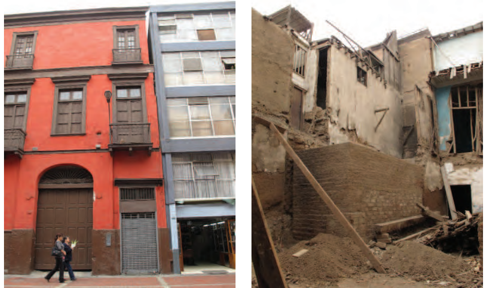
FIGURA 3.10 (IZQUIERDA) Fachada del jirón Carabaya (noroeste) y edificio adyacente de concreto, 2010. Imagen: Amila Ferron.
