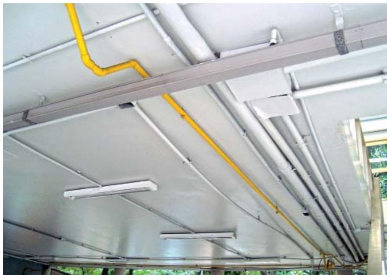
25 – Instalações aparentes percorrendo tetos nas varandas do primeiro pavimento – Visible installations on the first floor veranda ceilings
