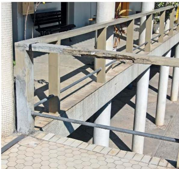
24 – Na imagem pode-se visualizar as perdas de material nos peitoris e montantes do guarda-corpo – The image shows the missing material from the handrail and railings of the guardrail
