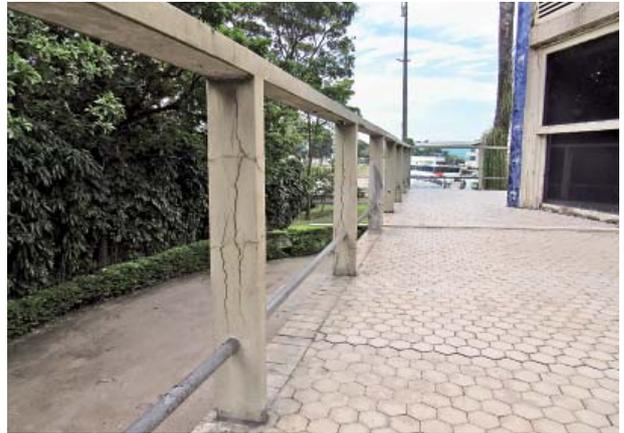
30 – Fissuras nos montantes do guarda-corpo – Cracks in the guardrail stiles
