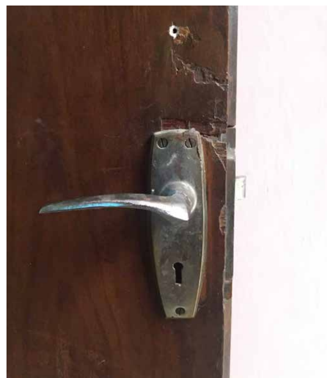
MATERIAL LOSS IN BOTTOM EDGE
