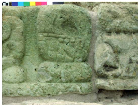
Figura 9. Área de pérdida de mortero abajo de un bloque (derecha); relleno de mortero a base de cal entre los bloques (izquierda). Foto cortesía de Hiroyuki Ikarashi.
