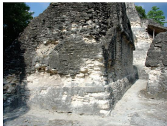
Figura 3. Ángulo Suroeste de la Estructura 5D-20 en Tikal. Nótese cómo las partes protegidas, bajo techo o bajo cornisas, presentan disolución mientras que las partes húmedas permanecen...
