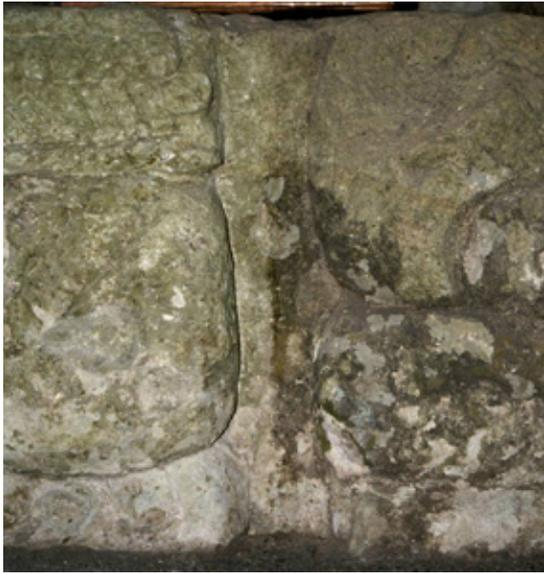
*Figura 10. Una zona después de la limpieza, la reducción de los tratamientos anteriores con hisopos y acetona, y los nuevos tratamientos de estabilización a base de cal (izquierda); una zona sin reducción o eliminación de tratamientos anteriores (derecha). Foto de Elsa Bourguignon*
