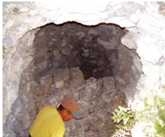
Figura 7. Proceso de relleno de túneles de saqueo
