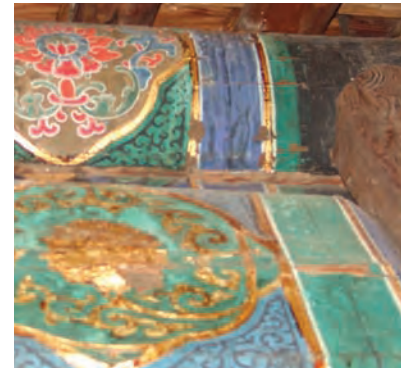
脊檩上的裂缝
