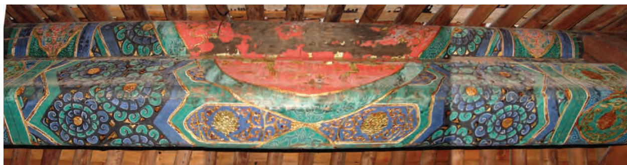
北面构件的合成照片
