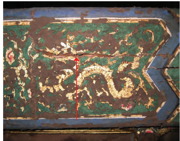
详细显示彩画表面脱落及额枋中部出现的水平开裂。
