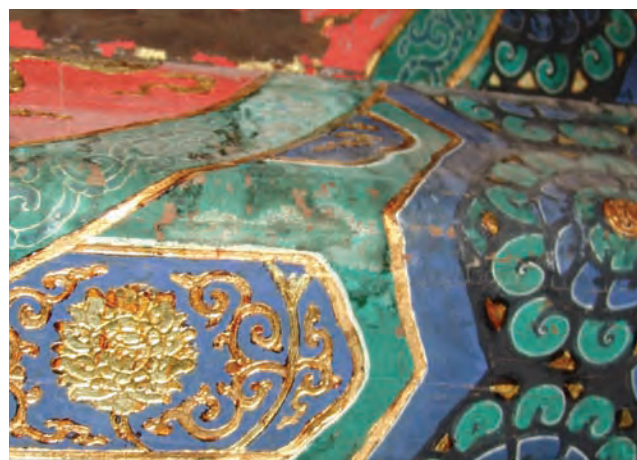
雨水渗透所造成的水渍。
