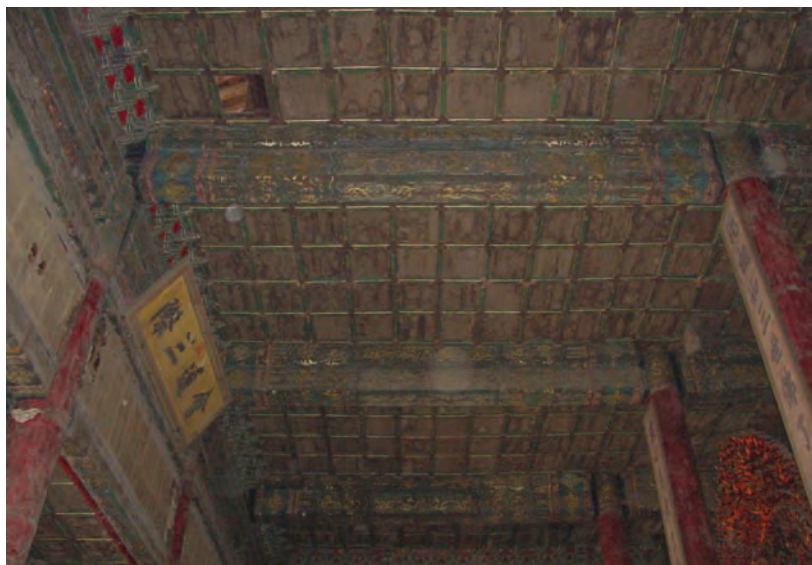
井口天花（自东向西看）。几乎所有天花彩画都已经脱落了。
