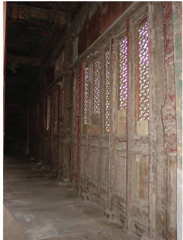
会乘殿北壁大门上油饰地仗的残破状况。
