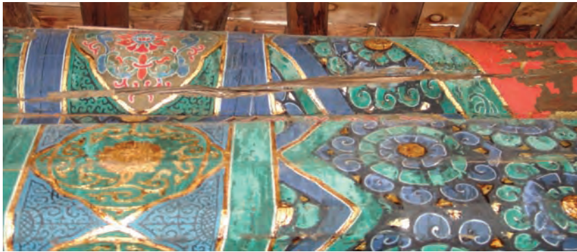
脊檩上的裂缝
