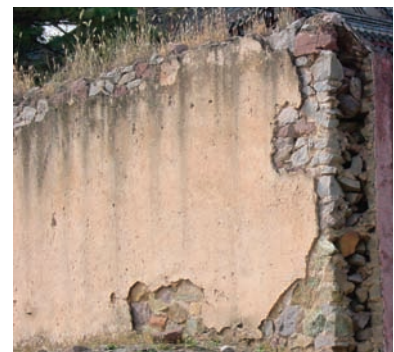
天王殿，室内西部 抹灰 脱落区域 Tianwang Hall, E interior Plaster Area of loss
