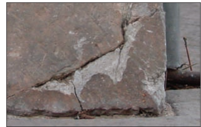
会乘殿，西北角 鸚鵡岩 裂缝（带有表面碎裂）
