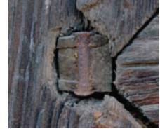
会乘殿，南立面 避雷针扣， 铁锈
