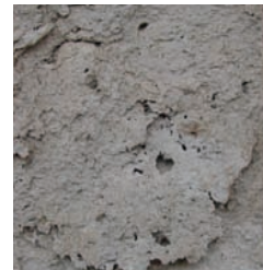
会乘殿，东北角 下碱 鸚鵡岩 石材起甲剥落与严重外表残损及可见盐分
