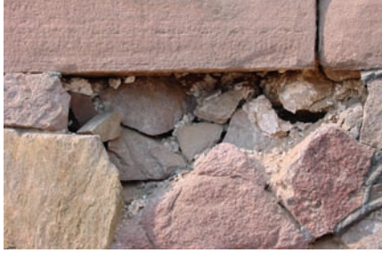
山门，南立面，台基 毛石砂岩及凝灰岩砌面 毛石缺失
