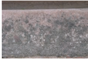
会乘殿，南侧台阶，垂直阶面 红砂岩 石材表面的生物生长导致了污迹和侵蚀
