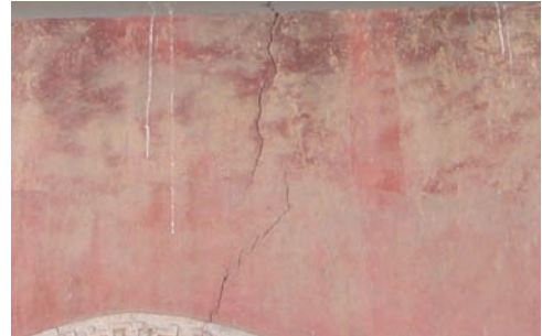
山门，北立面 红色抹灰 开裂 Shanmen, N Facade Red-colored stucco Cracking
