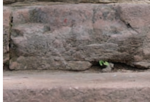
会乘殿，南侧台阶 红砂岩 石材表面的生物生长导致了污迹和侵蚀
