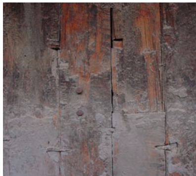
会乘殿，室内，北廊 扇面墙 表面堆积（大片地仗脱落后的 少部分地仗遗存） Huicheng Hall, Interior, N corridor Wood panel wall Surface deposit (remnant plaster after significant plaster loss)
