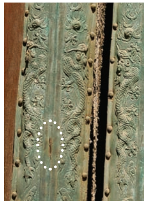
会乘殿，南立面 门扇青铜配件开裂
