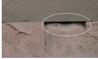
会乘殿，台基西侧 红砂岩 石材边缘局部缺失
