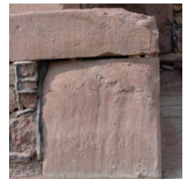
山门，台基东南角 红砂岩 被侵蚀的角部埋头石 Shanmen SE Platform corner Red Sandstone Eroded corners
