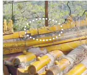
会乘殿，北立面，西侧 下檐 琉璃瓦 开裂及破损（两个不同部位）
