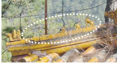
会乘殿，北立面， 东侧 下檐 琉璃装饰物 屋顶构件部分脱落 Huicheng Hall, N facade, E side Lower eave Glazed orna- ments Partial loss of roof elements
