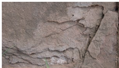
会乘殿，东部台基底部 红砂岩 底部伴随盐分析出的表层缺失
