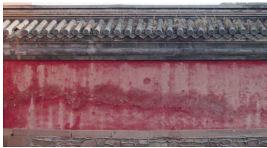
围墙，山门以西，内侧 红色抹灰 带状受潮痕迹
