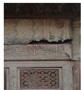
会乘殿，北立面 小额枋 表面堆积（鸟粪） Huicheng Hall, N Facade Lesser Architrave Surface deposit (bird droppings)
