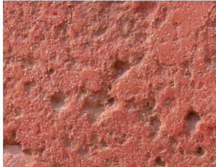
山门，室外南 红色抹灰 孔状脱落及凿痕
