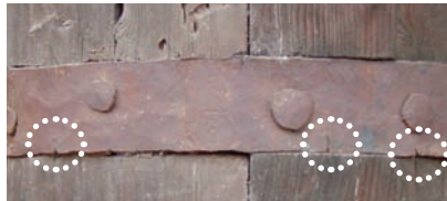
会乘殿，北立面 柱上铁箍 开裂及铁锈
