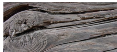
会乘殿，南立面 大额枋 发展中的开裂 Huicheng Hall, S Facade Architrave Progressive cracking
