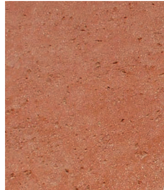
山门，室外南 红色抹灰 孔状脱落及凿痕
