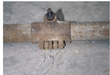
会乘殿，南踏步石 红砂石 搭脚手架所造成的损害
