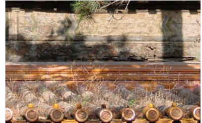
会乘殿，北立面 上檐 琉璃瓦顶 植物生长 Huicheng Hall, N facade Upper eave Glazed roof tiles Plant growth
