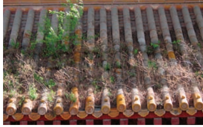
会乘殿，北立面 下檐 琉璃瓦顶 植物生长 Huicheng Hall, N facade Lower eave Glazed roof tiles Plant growth
