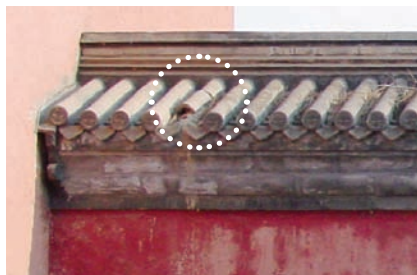
围墙，山门西侧 顶瓦 一片瓦位移
