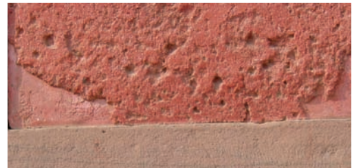
山门，南立面 红色抹灰 不和谐的新加抹灰
