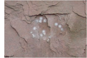
会乘殿，西侧台基， 红砂岩 昆虫巢穴（及片状剥落）
