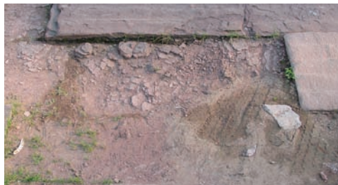
埽地石 红砂岩 表面瓦解及严重的材料 缺失
