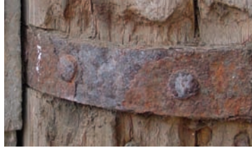
会乘殿，北立面 柱子铁箍，铁金属 锈腐及脱落
