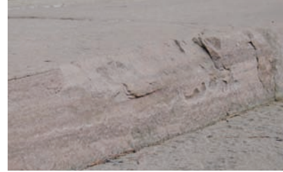
会乘殿，台基北侧踏步 红砂岩 侵蚀造成部分石材缺失
