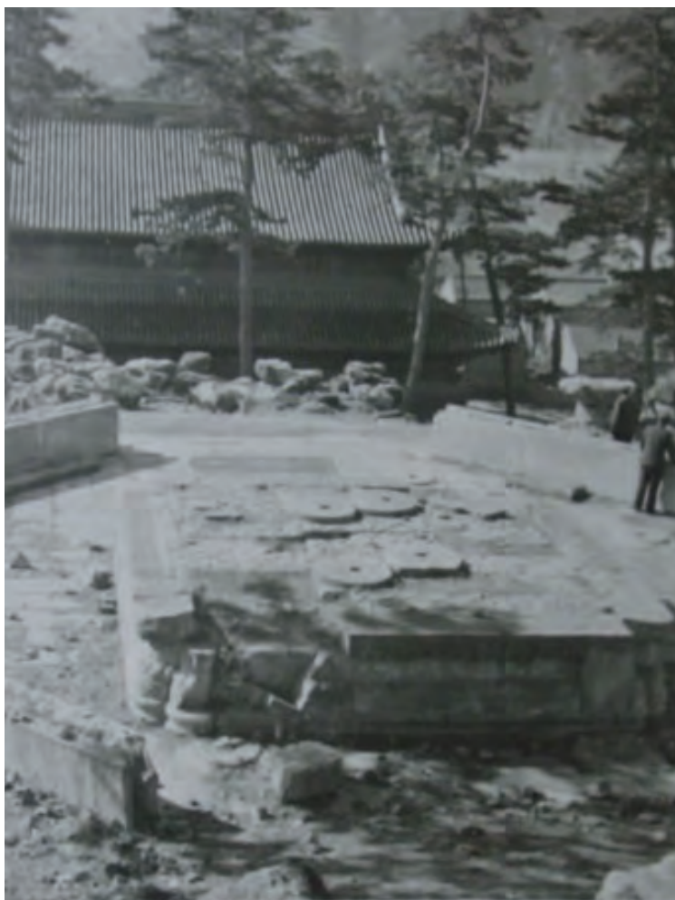
91. 1981年宝相阁槛墙和须弥座（在原址） Sill walls and statue base in Baoxiang Pavilion in situ in 1981
