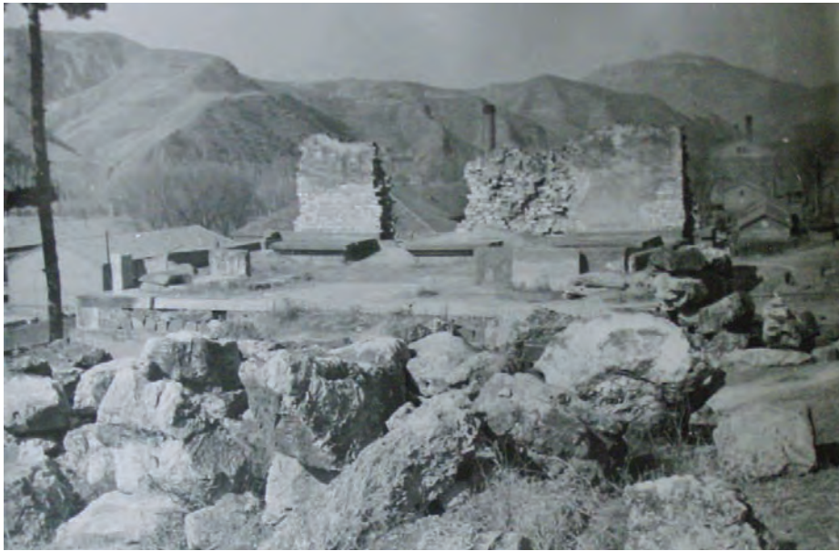
92. 1981年雪净殿，（朝西） Xuejing Hall in 1981, looking west
