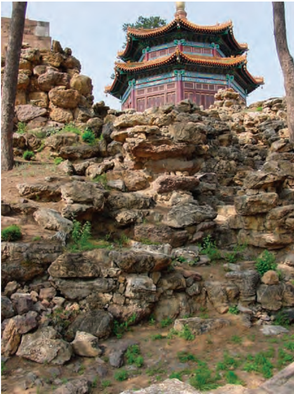
80. 会乘殿后边假山（朝东南方向的宝相阁） Rockery behind Huicheng Hall, looking NE to Baoxiang Pavilion
