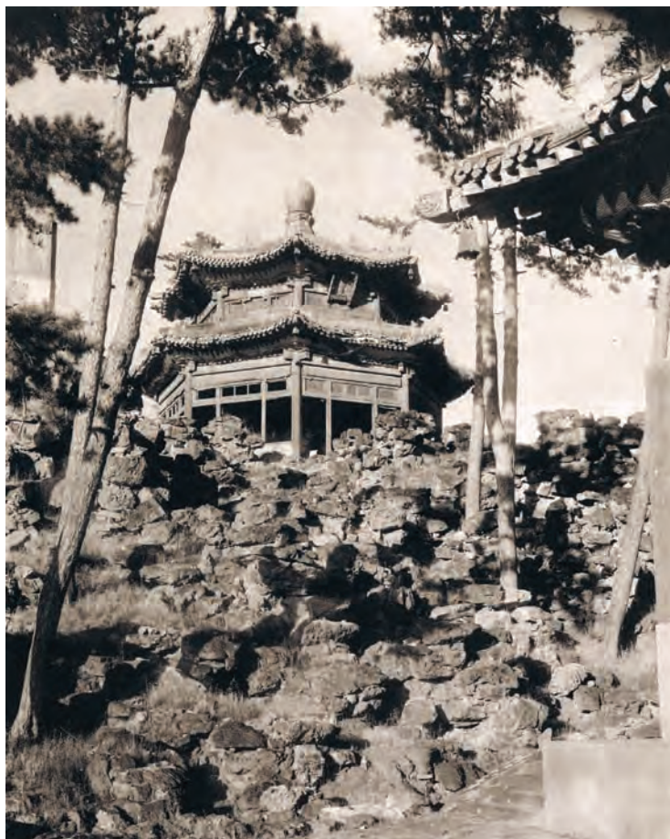
85. 从会乘殿西南角望宝相阁（1933年） Baoxiang Pavilion from the NW corner of Huicheng Hall (1933)
