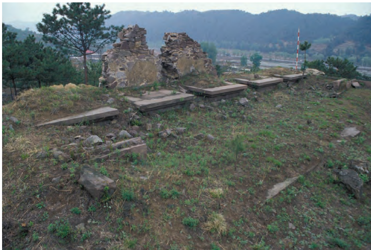
106. 吉晖殿（朝东南） Jihui Hall, looking SE
