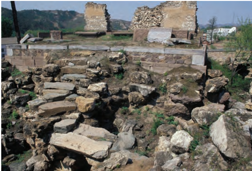
93. 2004年雪净殿（朝西） Xuejing Hall in 2004, looking west
