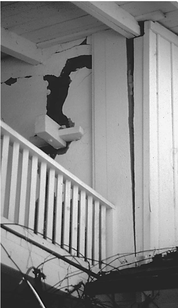
frecuencia para intentar estabilizar muros fuera del plano en construcciones de mampostería no reforzada. Desgraciadamente, estos amarres pueden provocar el agrietamiento vertical de los extremos de los muros, lo que agrava la inestabilidad de dichos muros, que no son portantes.
